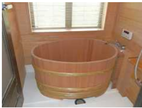
システムバスに設置 浴槽サイズ1200×800 深500 使用材料:吉野杉・竹くぎ・竹ひご・木栓
